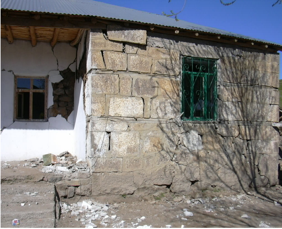
Şekil 1: Hafif ot örtülü ve ince saç-teneke kaplı çatılı bina
